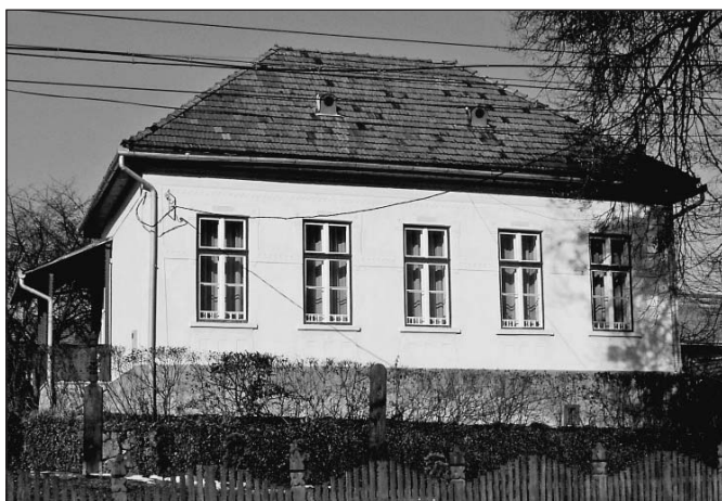
Az egykori szóvátai református felekezeti iskola épülete
